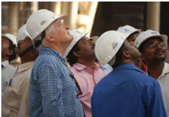
Arq. Carlos Ott con técnicos asiáticos haciendo dirección de obra.
